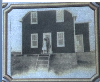
À gauche, première maison détruite par les flammes en 1964 et à droite, la propriété actuelle
