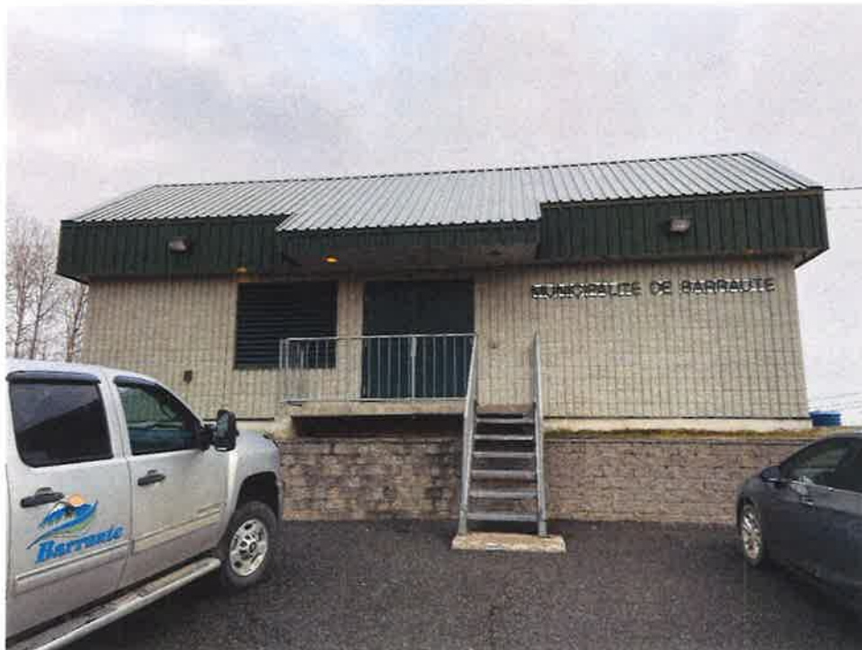
Photo 2 : Aperçu du bâtiment de production d'eau potable – 2020-10-20
