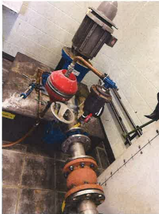
Photo 1 : Aperçu du puits PP-1-96 - 2020-10-20
